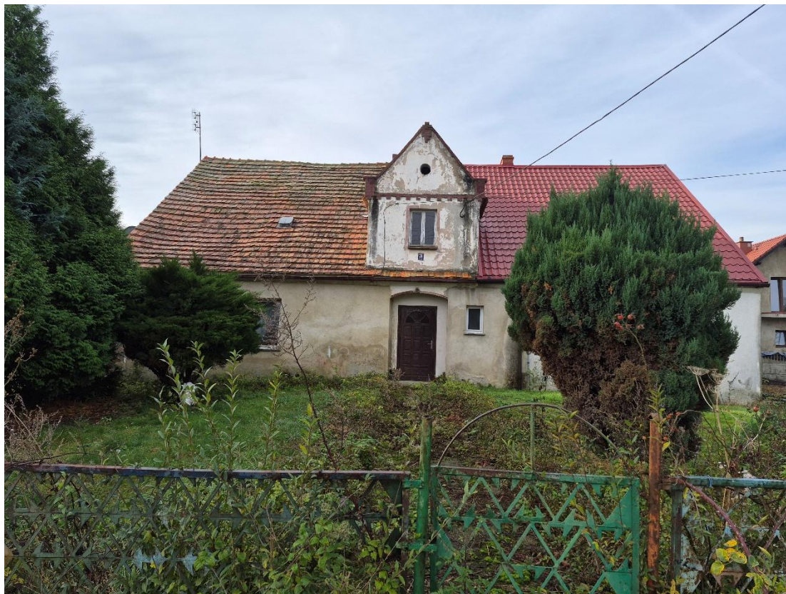
Budynek dawnej gospody (wł. prywatna)
